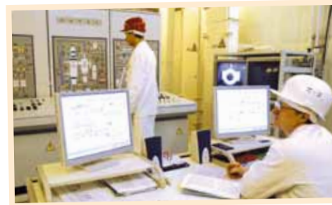
Пульт дистанционного автоматизированного управления установки сжигания РАО на ХТРО
