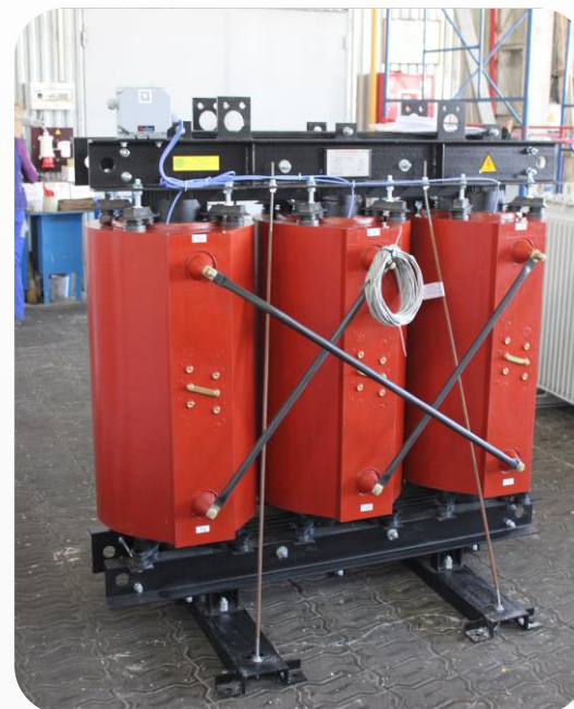
Трансформаторы сухие с литой изоляцией ТСЛ
